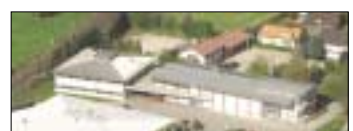
Büro- und Druckereigebäude, Bauherr: Anton Miller, Gebäudeplanung: Zeller+Romstätter, Traunstein, Tragwerksplanung: Haumann & Fuchs.
