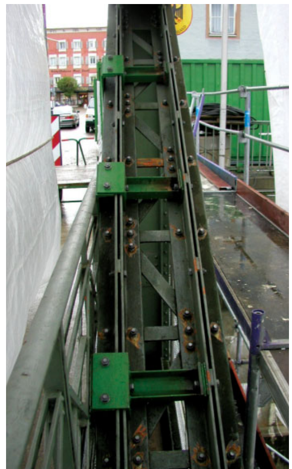
Bild 8. Provisorische Klammerkonstruktion zur Stabilisierung des Diagonalstabes während der Austauschmaßnahme
