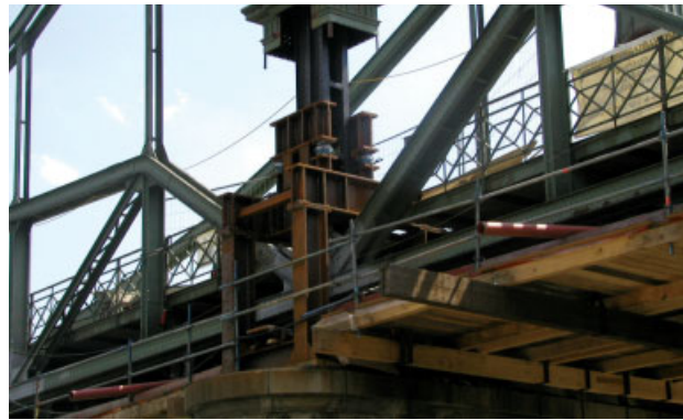
Bild 10. Hilfskonstruktion zum Anheben der Brücke im Pfeilerbereich
