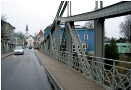
Bild 14. Teilansicht einer Fachwerkscheibe mit Geländer in der neuen Farbgebung Fig. 14. Partial view of a latticed arch with balustrade with new colouring
