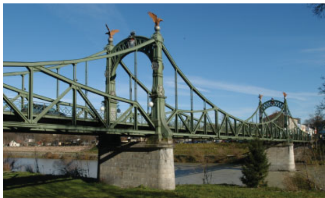
Bild 1. Ansicht der Brücke Fig. 1. View of the bridge
