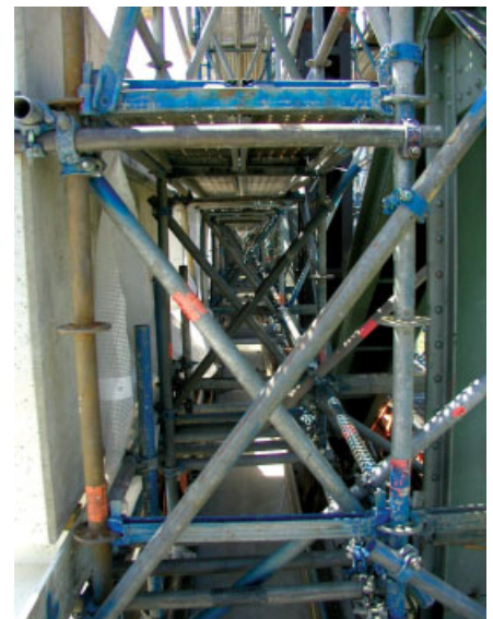
Bild 17. Arbeitsgerüst für die Strahlarbeiten
