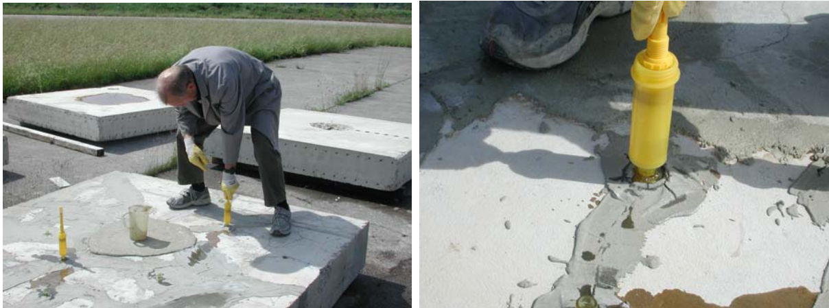
Bild 10: Anwendung der EP-Injektion mittels Selbstinjektor bei angesprengten Platten.
