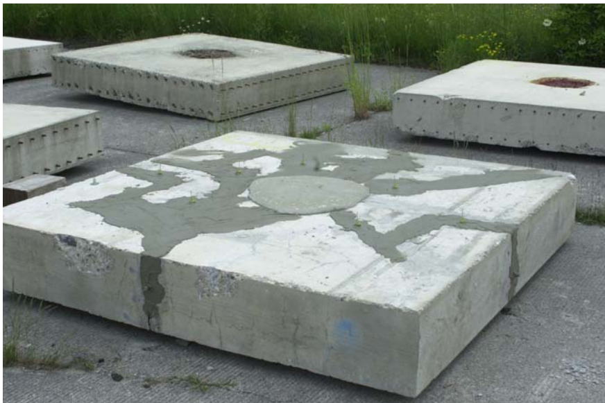
Bild 9: Geschädigte Stahlbetonplatte, vorbereitet zur Injektion.
