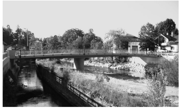
Bild 2. Neue Traunbrücke in Siegsdorf (Ansicht)
