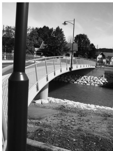
Bild 12. Fertiggestellte Brücke mit montiertem Geländer
