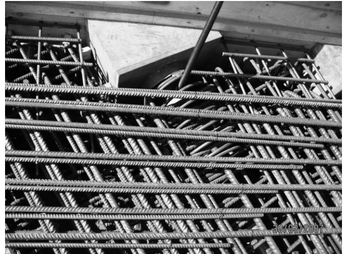
Bild 8. Querbewehrung im Bereich der Aufweitung
