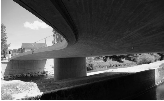
Bild 1. Neue Traunbrücke in Siegsdorf (Untersicht)
