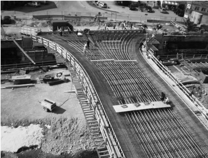
Bild 7. Bewehrungsarbeiten in der Draufsicht
