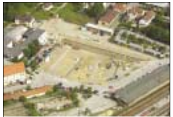
Derzeit im Bau: Annette-Kolb-Gymnasium, Eingabe- und Werkplanung: Zeller+Romstätter, Ausschreibung+Bauleitung: Strasser & Partner, Tragwerksplanung: Haumann & Fuchs.
