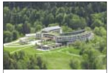
Resorthotel am Obersalzberg, Bauherr: Gewerbegrund Bauträger GmbH & Co, München, Prüfung der statisch-konstruktiven Unterlagen, Prüfingenieur Dr.-Ing. Walthari P. Fuchs.
