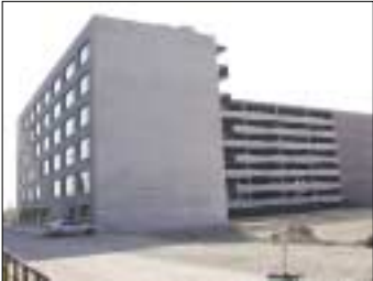
Neubau Bauzentrum und Parkhaus SOP 3 (ca. 680 Stellplätze), Bauherr: Regierungsbaumeister Max Aicher und Autopark Riem GmbH, Gebäudeplanung: Hild & K., München, Tragwerksplanung: Haumann & Fuchs.
